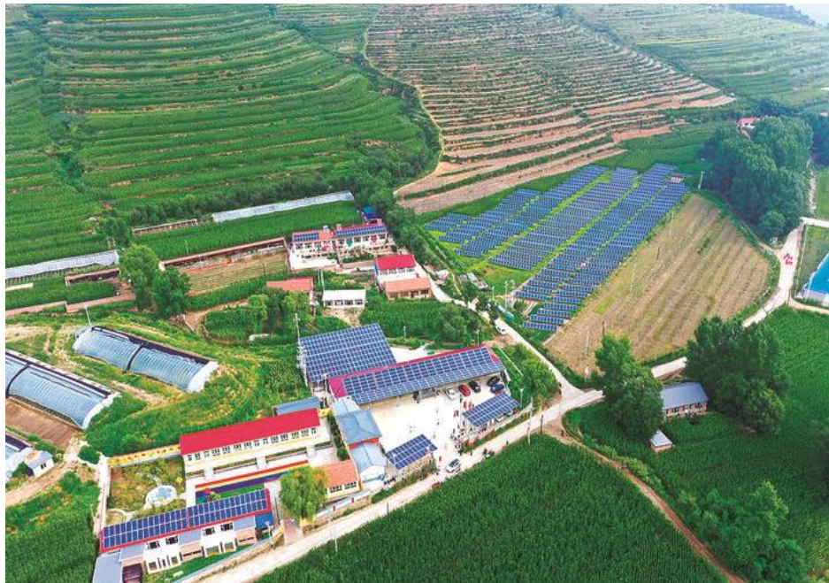
开滦集团为海字村建设的光伏电站。
